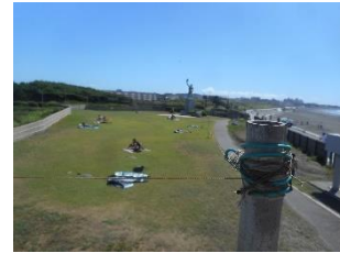
トビ対策糸張り ポールの設置
