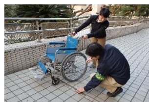
スロープの段差等の調査
