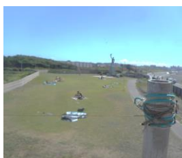
トビ対策糸張りポールの設置
