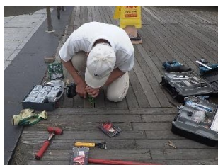
デッキ修繕の様子
