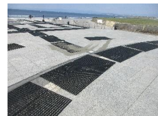
ゴムマットの敷設
