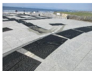
ゴムマットの敷設
