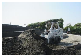
自社重機による 堆砂除去
