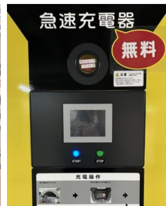
EV急速充電器
