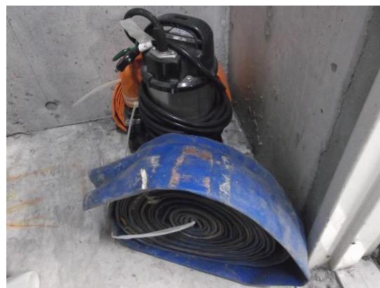
排水ポンプの準備
