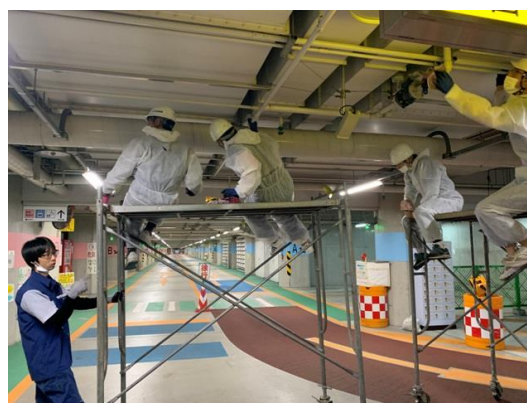
場内の粉塵除去作業
