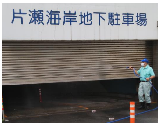
外部に面するシャッターの水洗い作業
